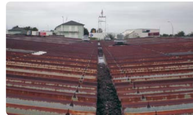
Toiture avant et après réhabilitation.
